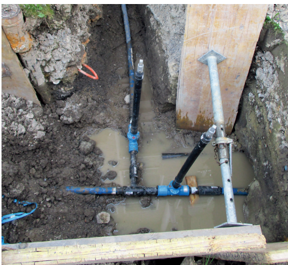
Fotos von Projekten des Rückblickes
